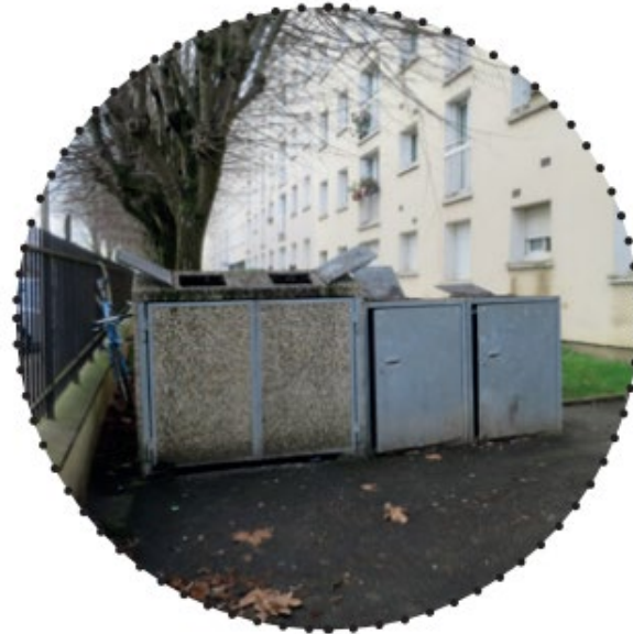
Suppression des abris existants
